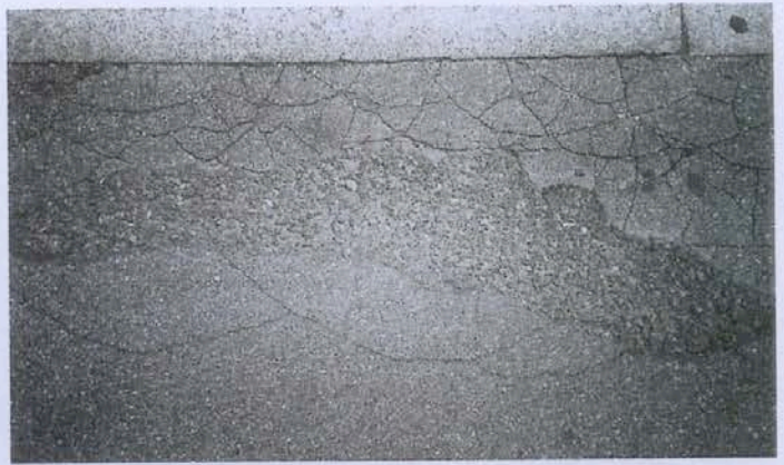
Teerboden mit einem Netz von Rissen, die an Spinnennetze erinnern, Wien | Tarred ground with a network of fissures reminiscent of spiders' webs, Vienna, 1999
